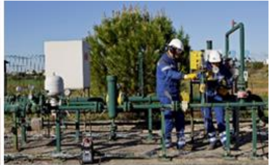
Salariés de GRTgaz en intervention sur un poste standard de détente livraison ©GRTgaz / Philippe DUREUIL
